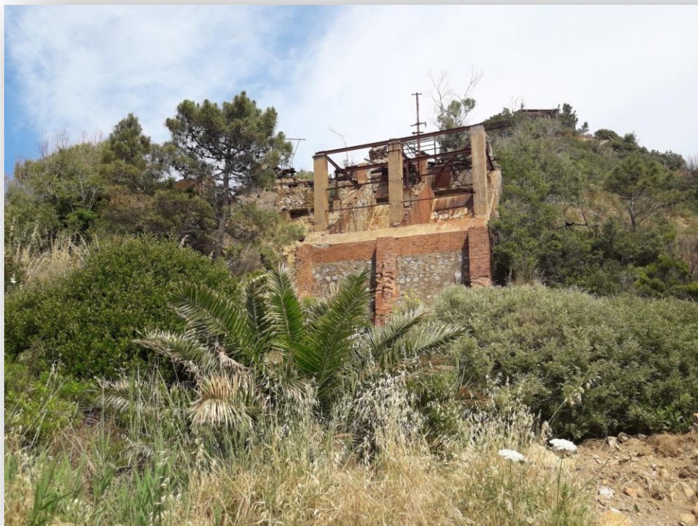
L'ex impianto filtrazione della Laveria Pirite Vigneria. (Foto Elena Leoni)
